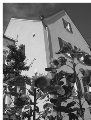
Pfarrhaus in Aufhausen nach der Renovierung.
