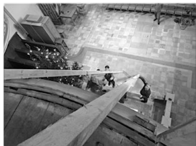
Hier geht's steil hinab: die Rutsche zum Abseilen der schweren Teile
